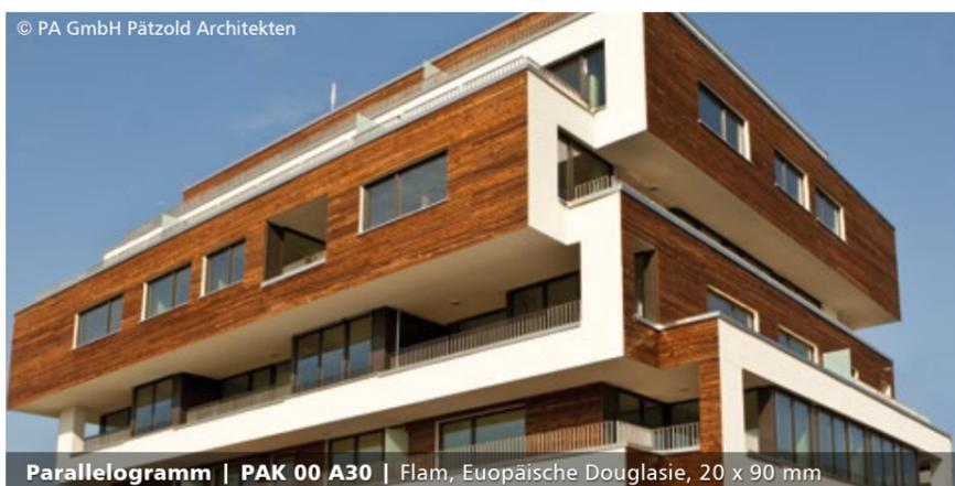
Parallelogramm | PAK 00 A30 | Flam, Europäische Douglasie, 20 x 90 mm
