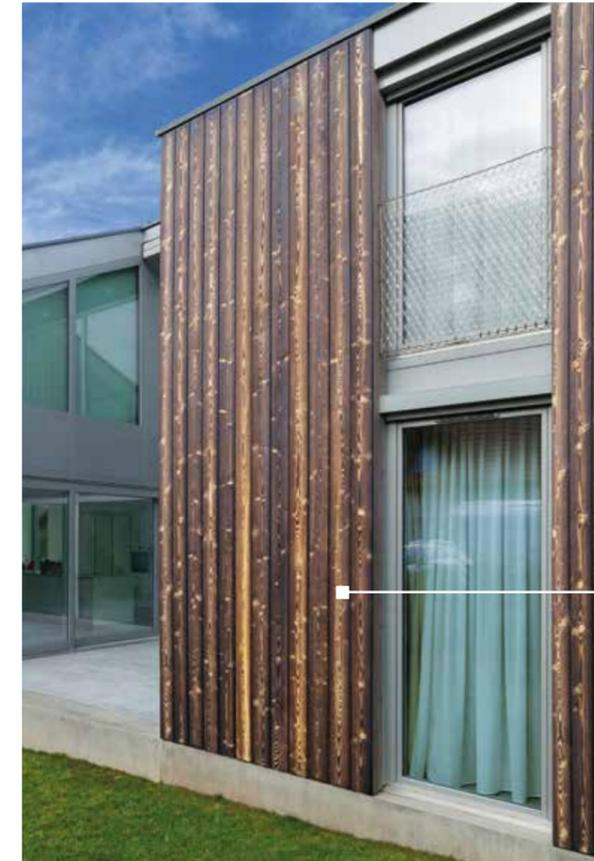
**Holzoberflächen mit Charakter für außen.** Durch leichte Beflammung behält die Oberfläche der Holzprofile ihre charakteristische Maserstruktur. Sie wird sogar noch deutlicher herausgezeichnet, da sich die weicheren und härteren Holzanteile unterschiedlich stark karbonisieren und verfärben. Eine Individualität, die durch die Wahl der Holzart und durch die Wahl der Oberflächenbearbeitung mehr Vielfalt bietet.
